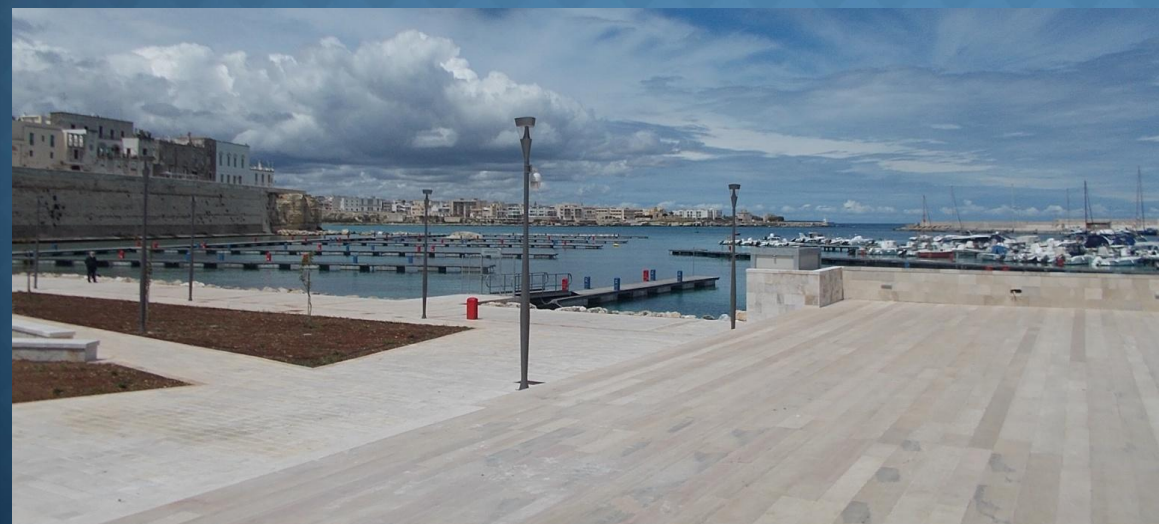
Banchina di riva, piazzale e pontili galleggianti
